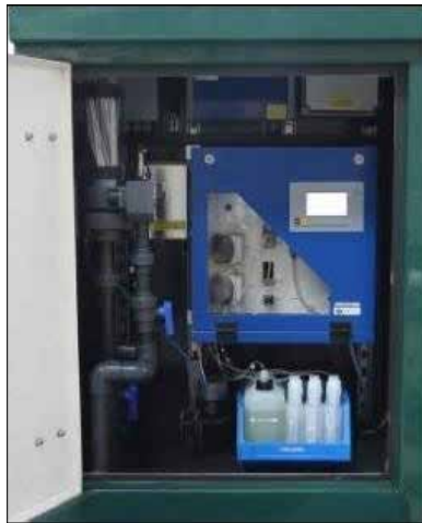
شکل ۷-۳۳. آنالایزر آنلاین فسفرکل و فسفات به همراه معرف ها و محلول کالیبراسیون در داخل کابین
