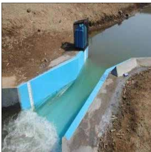
شکل ۷-۶۲. نمایی از یک فلوم بتنی ایجاد شده در مسیر جریان کانال خاکی
