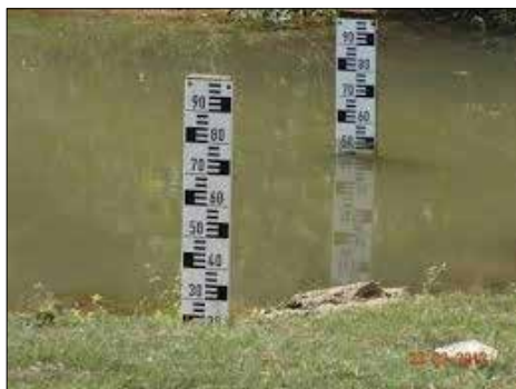
شکل ۷-۴۳. اشل نصب شده در داخل یک نهر
