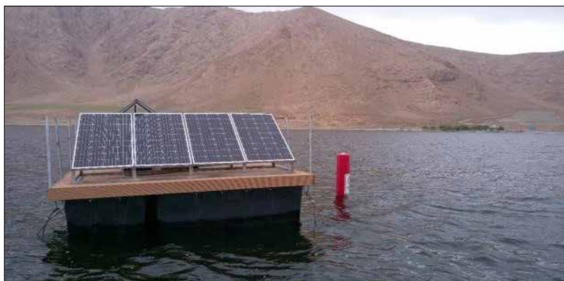
شکل ۹-۱۹. پانل های خورشیدی نصب شده روی اسکله شناور تالاب چغاخور
